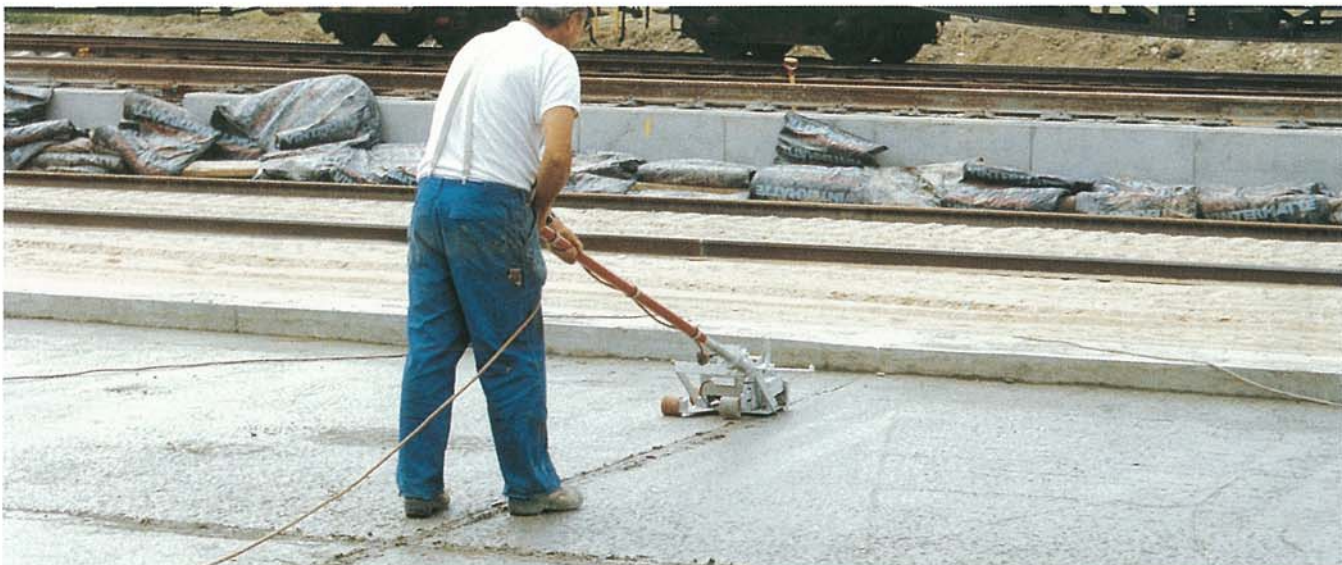
Skæring af fuger med Soff-Cut® maskine
