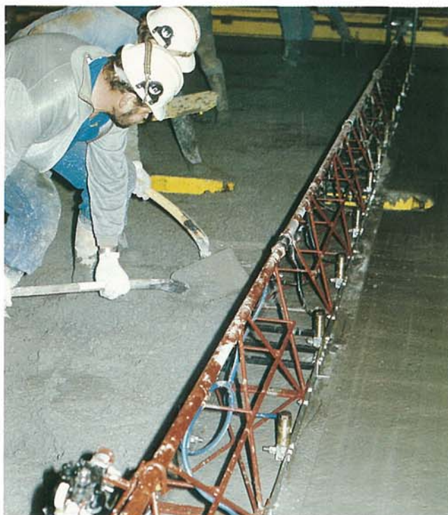
Udstøbning med trykluftdrevne bjælkevibrator. Den rette mængde beton foran vibratoren sikrer et optimalt resultat. Se bilag 8.
