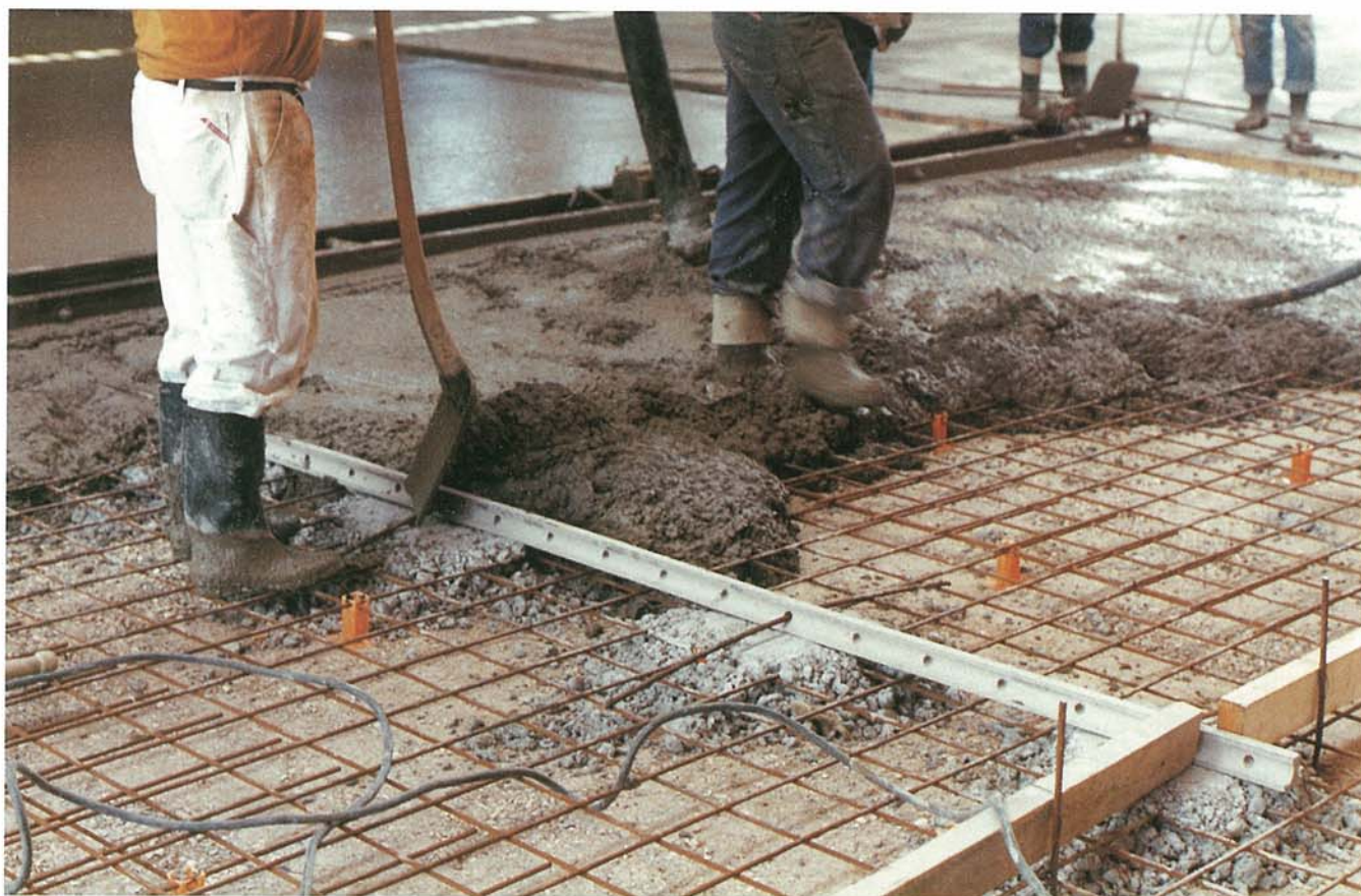
Udstøbning af armeret betonplade med dobbelt bjælkevibrator. Indstøbte ledere danner understøtning for bjælkevibratoren.
