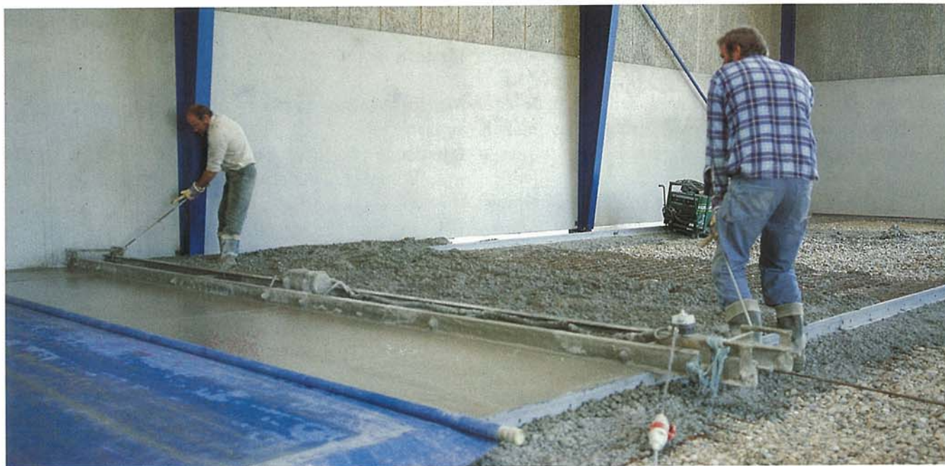
Gulvudstøbning med dobbelt bjælkevibrator. Der anvendes ledere, som tillader gennemgående armering. Den rette mængde beton foran bjælkevibratoren sikrer mod niveauforskelle og deraf manglende planhed.
