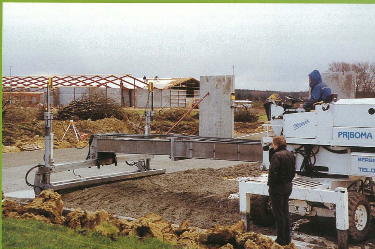
Udstøbning af betonplade med en laserstyret afretnings- og vibratormaskine.
