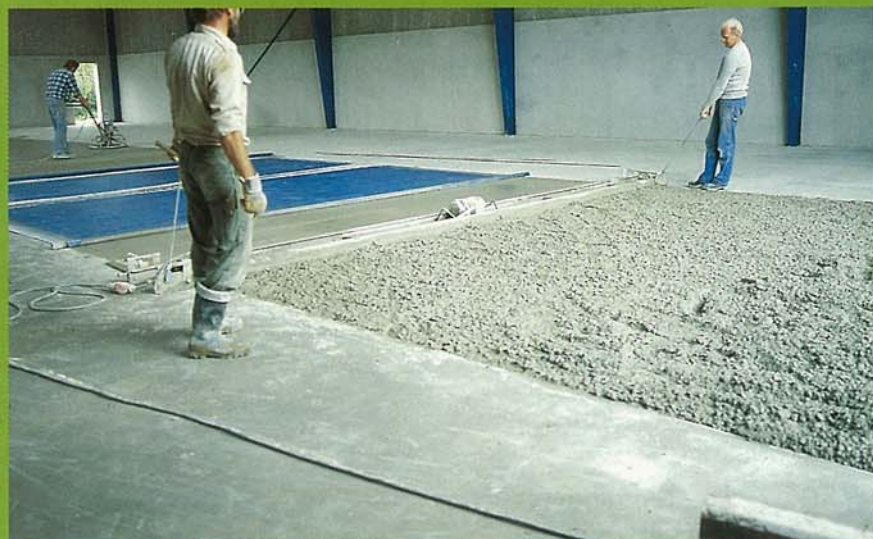
Afretning og komprimering med dobbelt bjælkevibrator. Komprimeringsdybden er 150 mm ved en konsistens på 60-160 mm.
