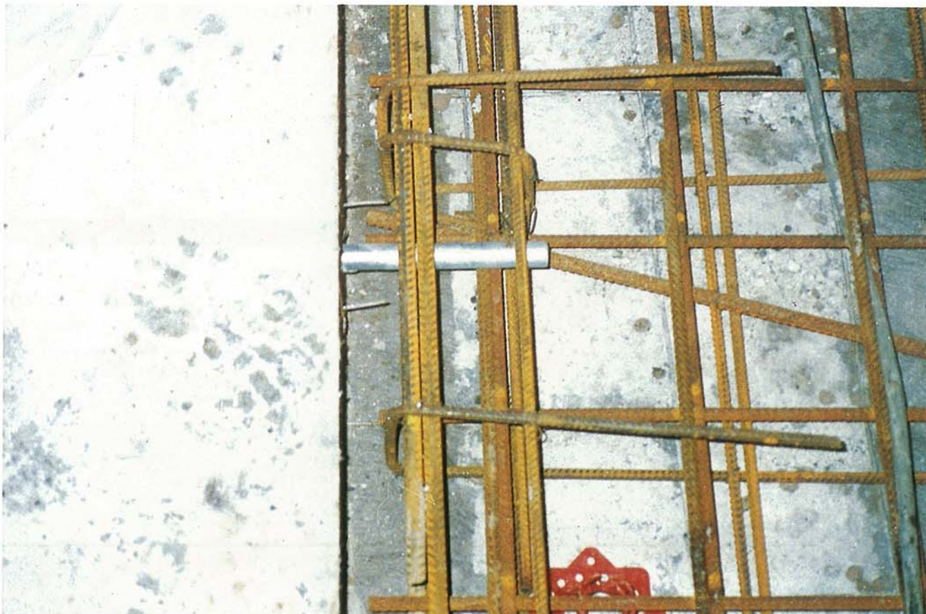
Kontraktionsfuges med dyvel indstøbt, der bevirker, at vertikale kræfter kan overføres. Dyveln påføres en vedhæftningsbryder inden udstøbningen
