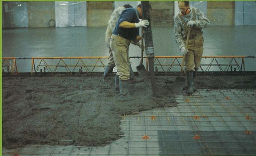
Udstøbning af gulvkonstruktion og efterfølgende afretning og komprimering med luftdrevne bjælkevibrator..
