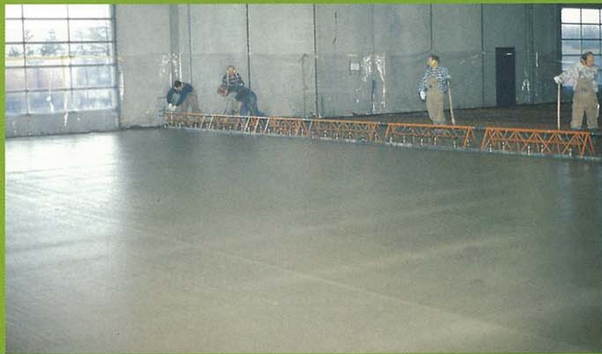
Den luftdrevne bjælkevibrator kan med fordel anvendes ved store arealer. Komprimeringsdybden er op til 350 mm ved en konsistens på maksimalt 100 mm.
