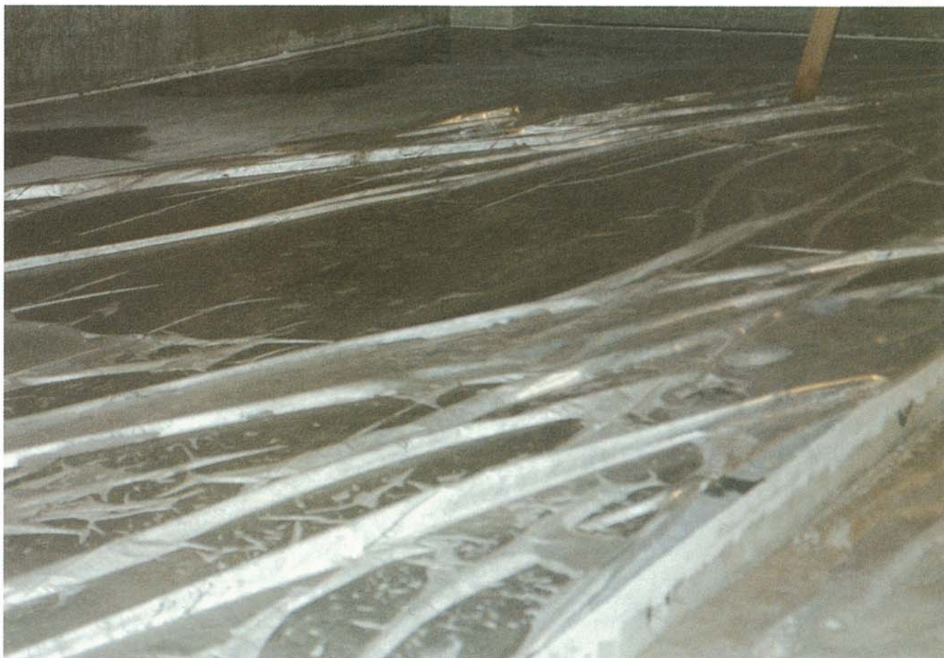
Beskyttelse af betonen med plastfolie efter at overfladen er blevet vandet.
