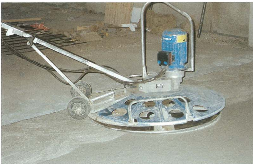
Glitning af gulv med almindelig enkelt glitemaskine monteret med planeringsplade.
