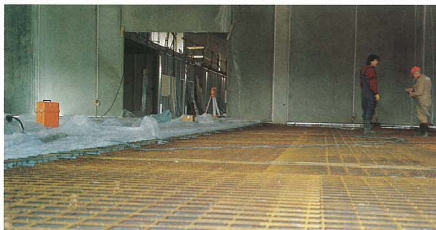
Armeret gulvkonstruktion, der er klar til udstøbning. Armeringens placering kontrolleres inden udstøbning.
