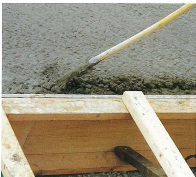
Ved pladetykkelser større end 100 mm og ved anvendelse af dobbelt bjælkevibrator, komprimeres der desuden med stavvibrator langs alle fuger og kantbegrænsninger. Se bilag 8.
