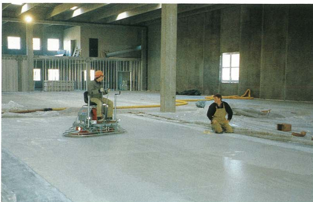
Glitning af gulv med dobbelt vingeglitter. Afdækning i form af plastfolie udlægges umiddelbart efter at glitningen er afsluttet.
