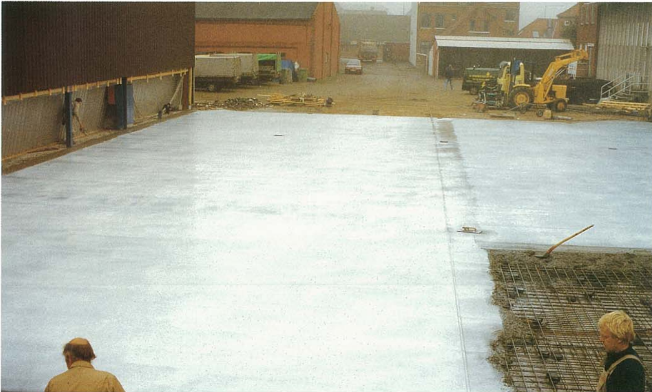
Umiddelbart efter udstøbning beskyttes betonen ved påsprøjtning af en hvidpigmenteret curingmembran.
