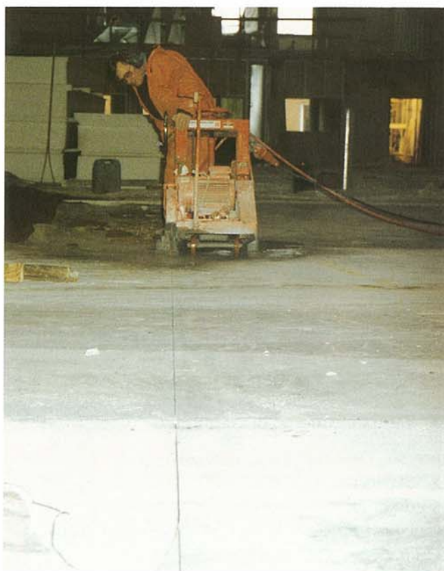
Skæring af fuger med diamantskæremaskine.
